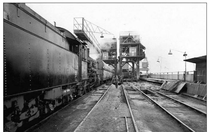
Bild 9 Werklok 23 (Baureihe 55) drückt die Waggons in die Kippanlage des Erzlagers. (Foto Lothar Meyer)
